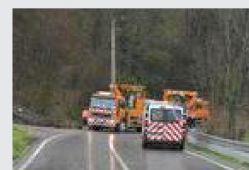
Une équipe de Resa est intervenue sur place. © Pierre Neufcour
